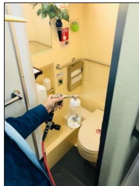
抗菌・抗ウイルスコーティングの施工の様子
